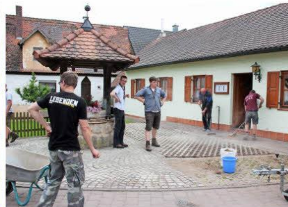
Eine Gruppe pflasterte als Dankeschön vor dem Gemeindehaus in Haid.
